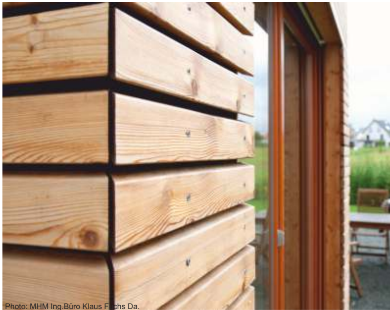
Photo: MHM Ing.Büro Klaus Fuchs Da.
