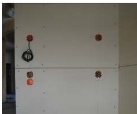
Photo : Habillage mural avec des plaques de plâtre
