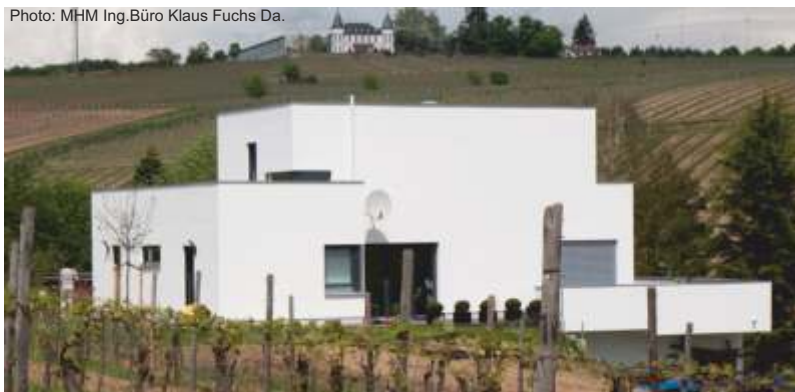
Photo: MHM Ing.Büro Klaus Fuchs Da.
