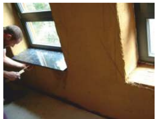
Photo : Habillage mural avec des panneaux en pisé
