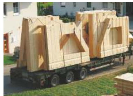
Bild: Anlieferung der Wandelemente
