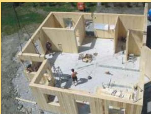
La préfabrication millimétrique des éléments de **Massiv-Holz-Mauer®** conduit à un assemblage simple, sûr et économique, avec l'installation des systèmes électriques et sanitaires. Avec le système du **Massiv-Holz-Mauer®**, les maisons sont fournies avec des qualités physiques remarquables.
